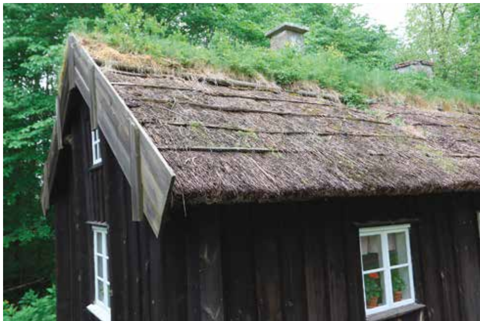
PÅ TAKET. Ursprungligen var det halmtak på stugorna, men långhalm från handtröskad råg finns knappt att få tag i längre. Det blev vasstak med halm och torv bara vid nacken istället.
