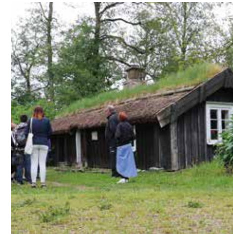
MODERNARE. Under 1800-talet vann modernare byggtkniker framsteg. Då ersatte reglade stommar den gamla korsvirketekniken. Samtidigt vann falu rödfärg terräng, liksom tegel på taket.
