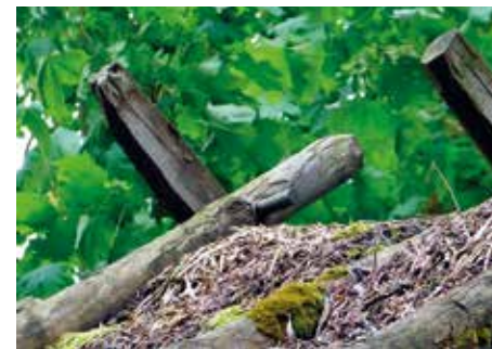
PLUGGAT. Halmtak, nocktätat med torv och gräs, hölls på plats med stockar som fästs ihop med trädpluggar.
