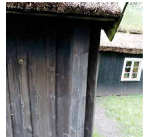
BRUTALRENOVERING. 1936 ändrade timmerhusens karaktär. Nästan alla de åtgångna fasaderna brädfodrades då, vilket ger ett lite märkligt intryck på ryggåsstugorna. Bara en enda fasad har kvar den ursprungliga timmerfasaden - sju stockar hög. Men färgen stämmer, för sådan lyx som att måla husen fanns det inte pengar till på Tån.
