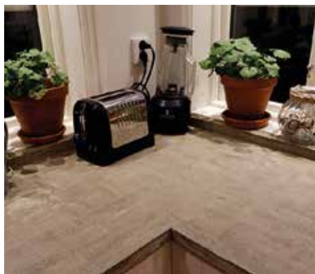
HANTVERKSJOBB. Ett krav Zimon hade var att bänkskivan skulle vara helt skarvfri. Lösningen blev att gjuta den på plats i finbetong.
