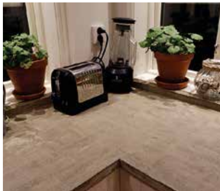
HANTVERKSJÖBB. Ett krav Zimon hade var att bänkskivan skulle vara helt skarvfri. Lösningen blev att gjuta den på plats i finbetong.
