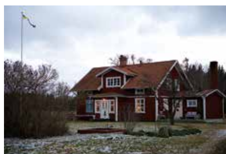
KRÅKERUD. Under 10 års tid har Maria och Per renoverat gården. Boningshuset börjar nu blir klart och växthuset är på plats sedan i höstas. – Nu tar vi tag i trädgården.
