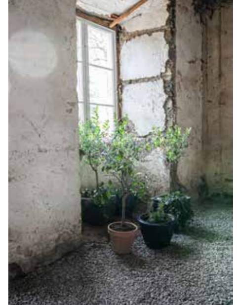
VINTERFÖRVARING. I denna del av huset fanns förr bland annat vishusboden. Här får olivträden bo under vintern under tiden som familjen renoverar klart. Åtskilliga timmar av grävning och gruslass har gått åt för att lägga grunden till ett nytt golv.
