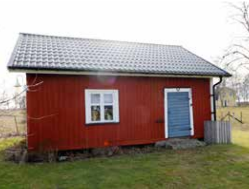
F.D SLAKTBOD. Den lilla röda byggnaden har anor från 1700-talet och är en av de allra äldsta i trakten. Den flyttades hit runt år 1900 och bytte då skepnad från magasin till traktens slaktbod. Idag rymmer den Marieths utrustning för odling och trädgård.
