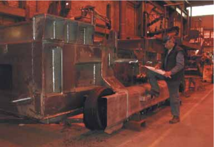
Ett chassi till mobilt krossverk under tillverkning av Ersgård Plåt & Svets AB för SRG.
