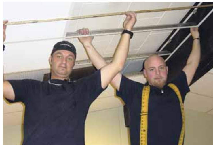
På bild. Martin Johansson och Tomas Arro i fart med att montera ett innertak i en förskola i Smygehamn.
