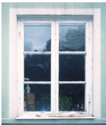
Gammalt träfönster före bytet
