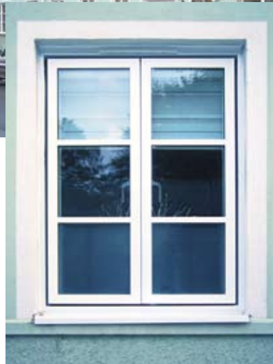
Montage av VELFAC 200 i befintlig karm. Den gamla karmen har klätts med aluminium
