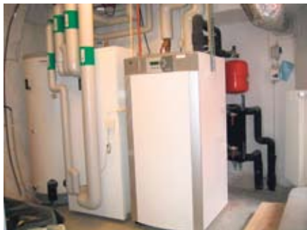
Värmepumpinstallationen i Gamla Stan
