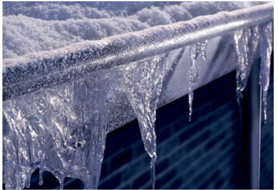
Isproblem löst med värmekabel.
