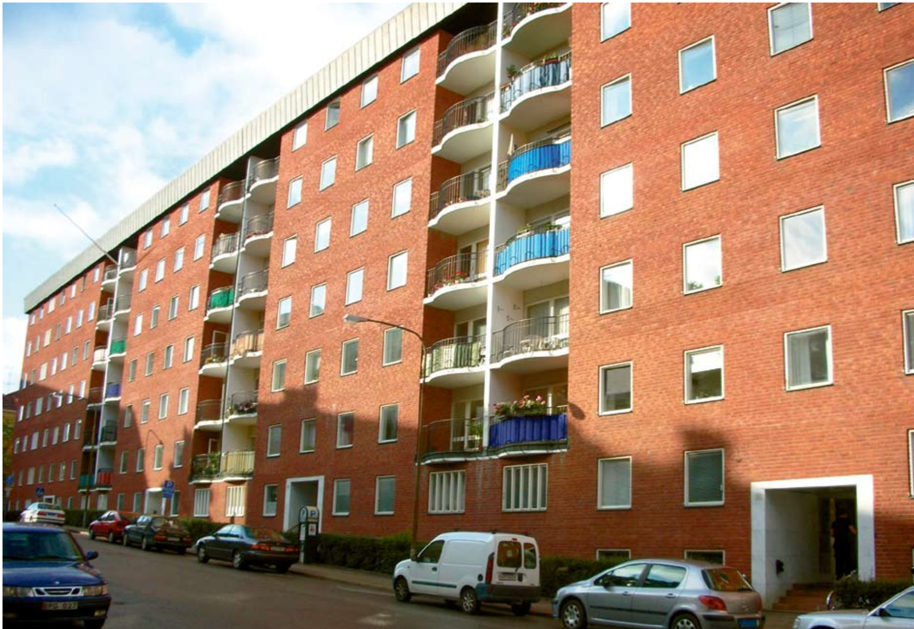
Ett av pilotprojektens fastigheter i Stockholm
